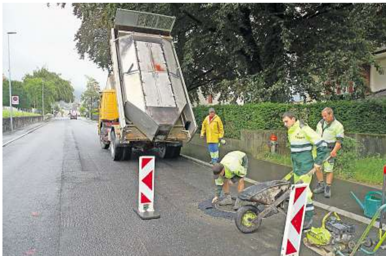
Gegenwärtig laufen die letzten Vorbereitungsarbeiten für den Eintrag des Deckbelages.
